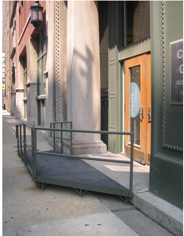
Rampa lateral portátil ha sido instalada para que esta entrada a la universidad sea accesible
